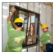
Крепление оконных рам к различным видам оснований
