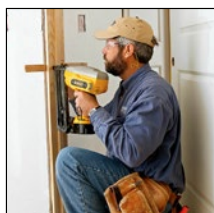
Крепление входных дверей
