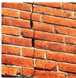
Ремонт и реставрация кирпичной кладки.
