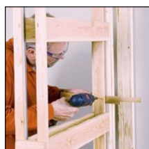
Крепление направляющих для лёгких конструкций
